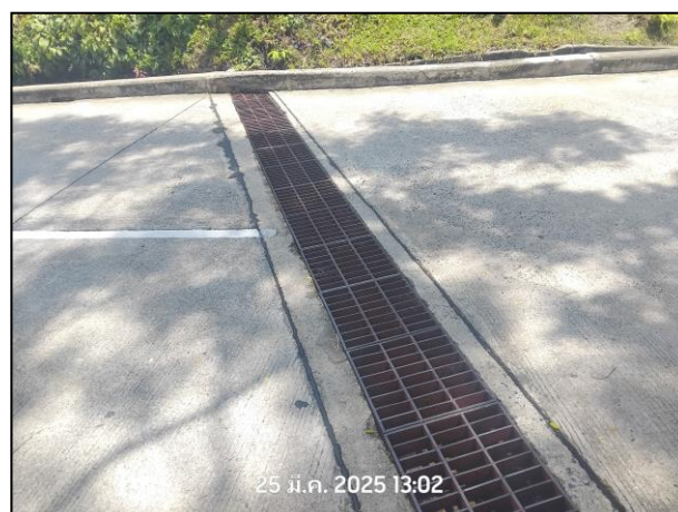
รูปที่ 2.12. ตะแกรงดักขยะ
